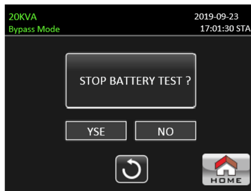
Отмена теста АКБ
