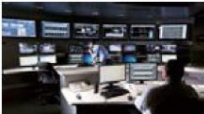
Центр управления и контроля
